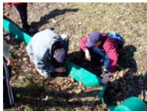
Montaż nie jest taki łatwy... instalacja ogrodzenia
